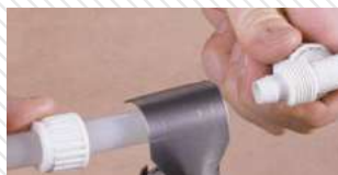
Монтаж пластиковых труб
